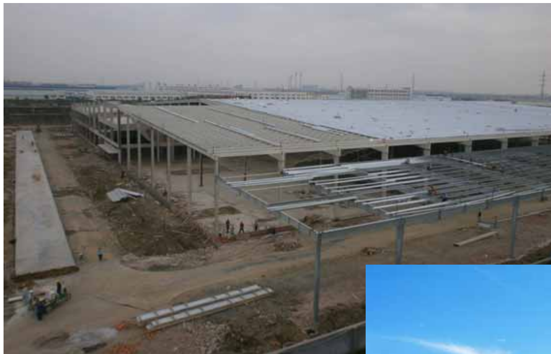
東洋飲料(常熟)有限公司工場建設風景 2011年10月現在
